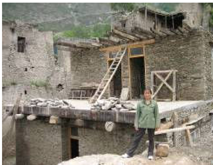
理縣通化鄉西山村一位羌族婦女祁香君修建中的新房子
